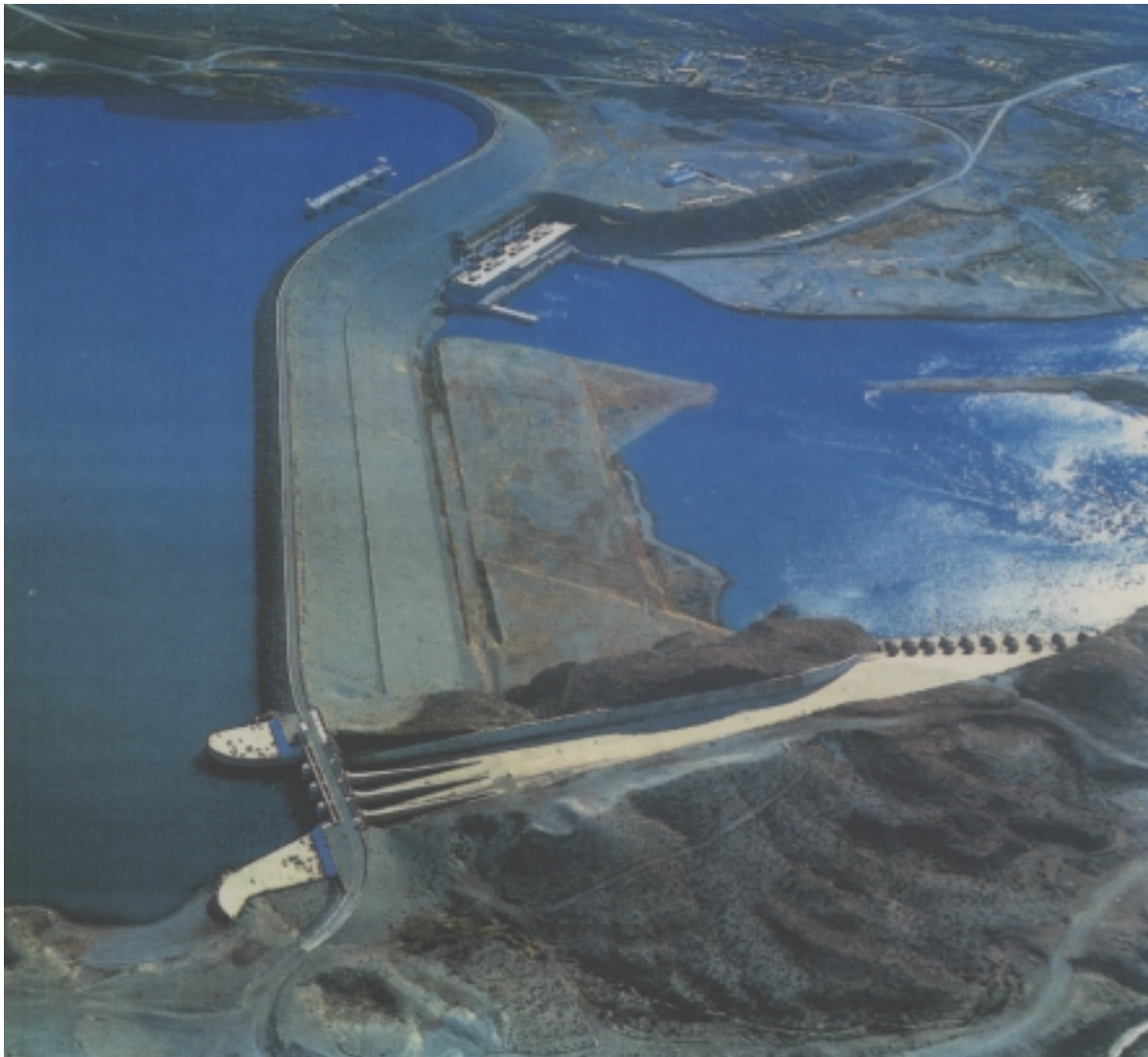
El Chocón. Vista panorámica de la presa, la central y el aliviadero
