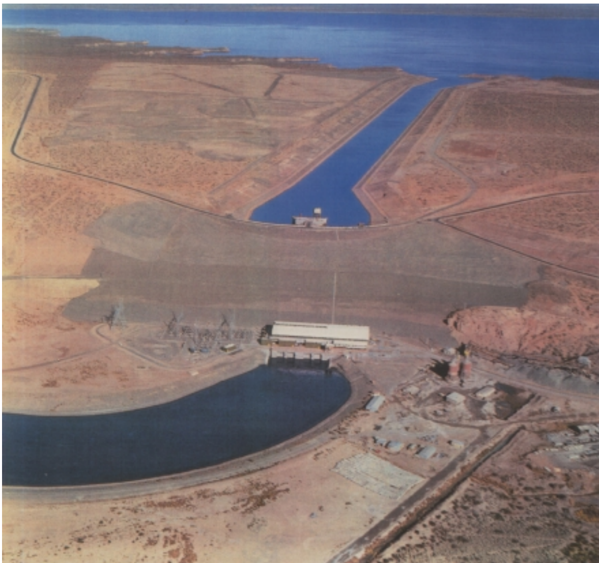
Planicie Banderita. Vista aérea de la central de 450.000 kW. Al fondo, cuenca Mari Menuco y canal de aducción.
