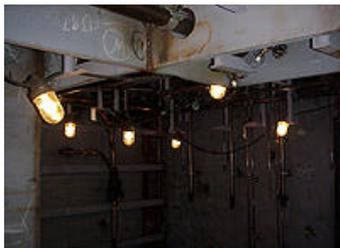
Bombillas protegidas con globos & cubiertas. Suspendidas y escondidas
